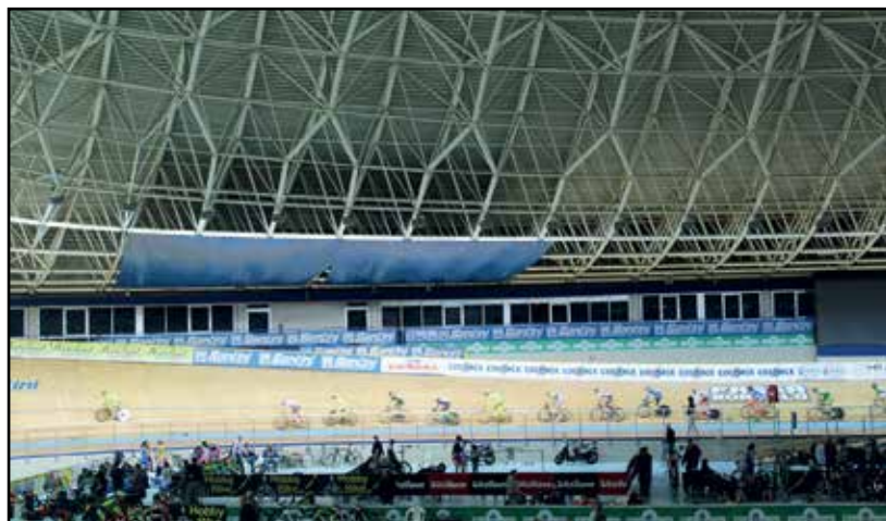
Telone azzurro per contenere le perdite del tetto.
